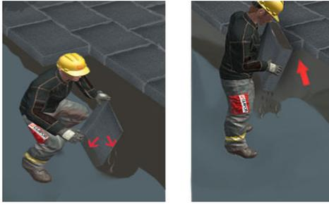
Dämmplatten diagonal einschieben
