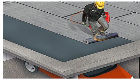
Trennlage mit Überdeckung verlegen
