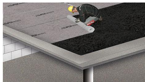
ggf. Glasgittergelege über Geotextil verlegen
