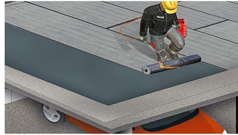
Trennlage mit Überdeckung verlegen
