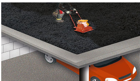
Schaumglasschotter verdichten
