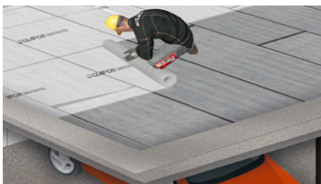
Trennlage mit Überdeckung verlegen
