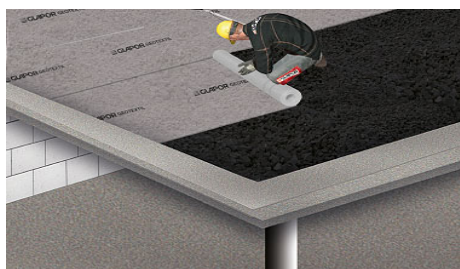
Trennlage mit Überdeckung verlegen
