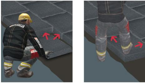
Dämmplattenkanten in Heißbitumen tauchen
