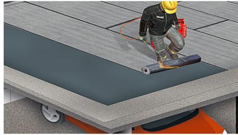
Trennlage mit Überdeckung verlegen
