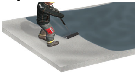
Reinigen und Grundieren
