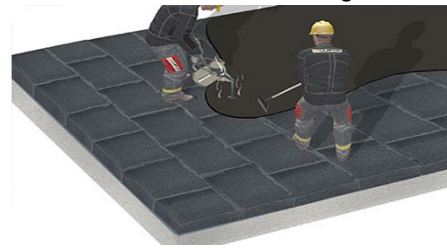
Zellfüllenden Deckabstrich aufbringen
