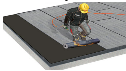
bituminöse Abdichtung herstellen
