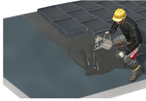
Platten vollflächig in Heißbitumen verlegen
