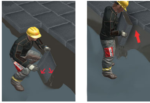
Platten diagonal einschieben
