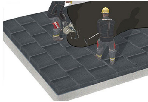
Zellfüllenden Deckabstrich aufbringen
