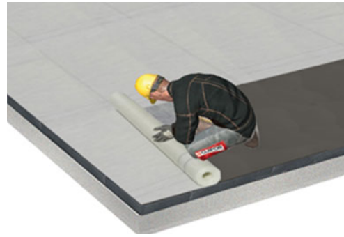
Kunststoffabdichtung lt. Herstellervorschrift
