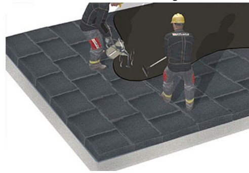
Zellfüllenden Deckabstrich aufbringen
