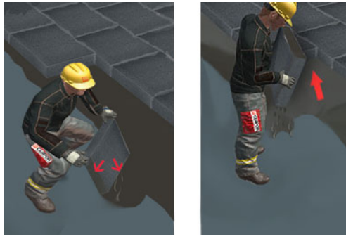
Platten diagonal einschieben
