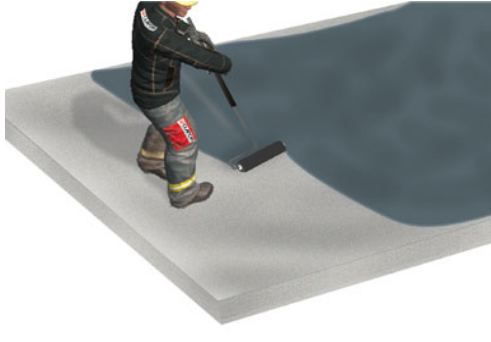
Reinigen und Grundieren
