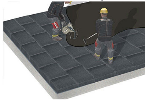
Zellfüllenden Deckabstrich aufbringen
