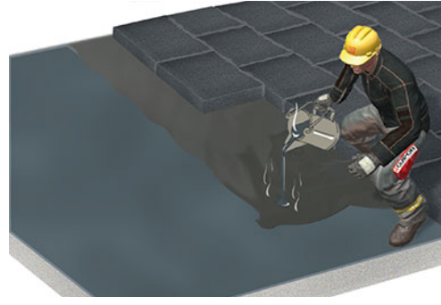
Platten vollflächig in Heißbitumen verlegen
