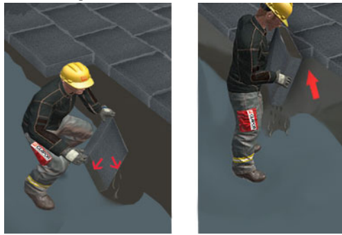
Platten diagonal einschieben
