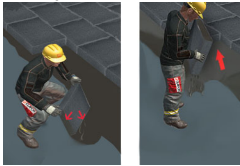
Platten diagonal einschieben
