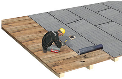
Reinigen und Trennlage verlegen
