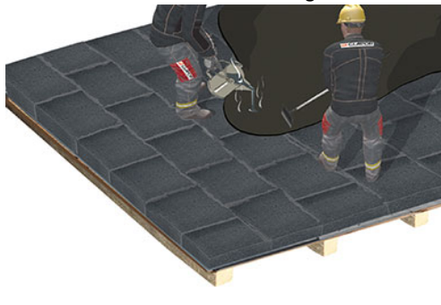
Zellfüllenden Deckabstrich aufbringen
