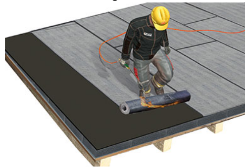
bituminöse Abdichtung herstellen
