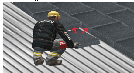
Platten diagonal einschieben
