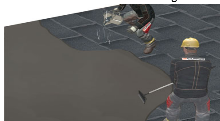
Zellfüllenden Deckabstrich aufbringen
