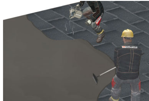
zellfüllenden Deckabstrich aufbringen
