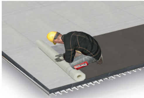
bituminöse Abdichtung herstellen
