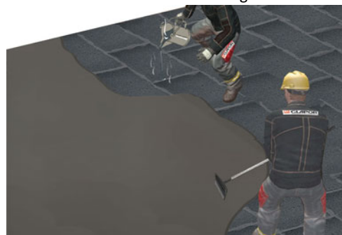
zellfüllenden Deckabstrich aufbringen
