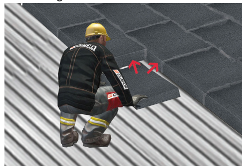
Platten diagonal einschieben
