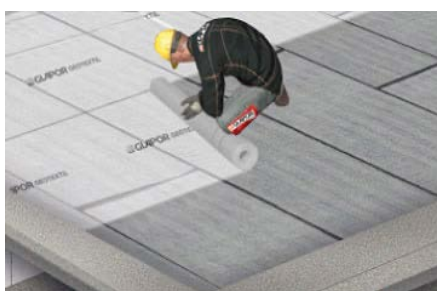
Trennlage mit Überdeckung verlegen
