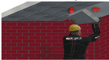
Platten auf Deckenfläche verlegen
