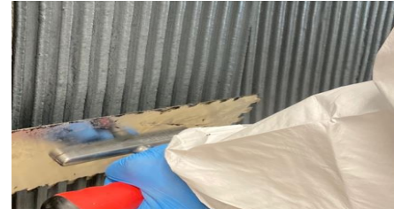
Systemkleber auf Untergrund aufkämmen
