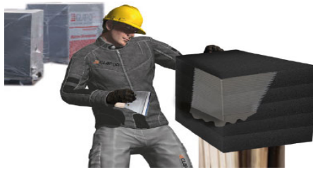
Plattenseitenflächen beschichten
