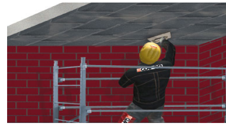
Unebenheiten verschleifen
