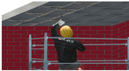
austretenden Kleber entfernen
