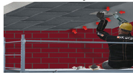
Platten mechanisch befestigen
