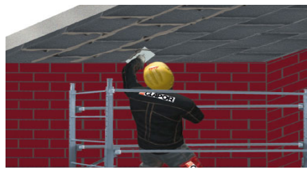
austretenden Kleber entfernen
