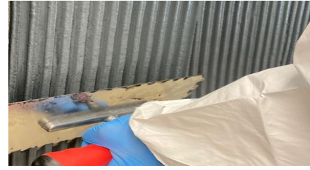
Systemkleber auf Untergrund aufkämmen
