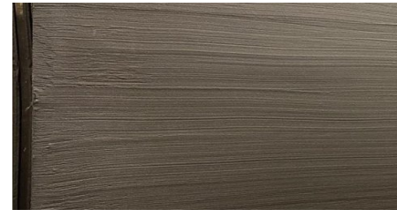
zellfüllenden Deckabstrich auftragen
