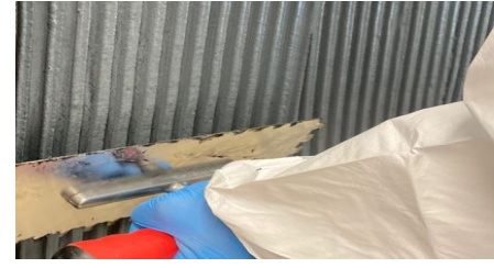
Systemkleber auf Untergrund aufkämmen
