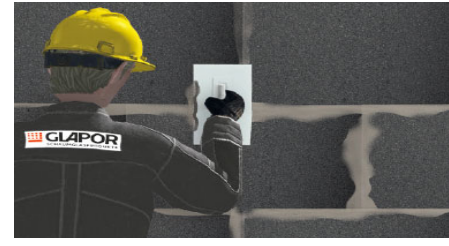
austretenden Kleber entfernen
