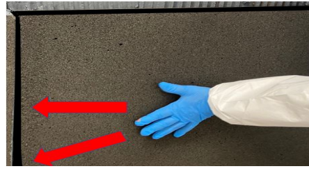
Platten auf Wandfläche verlegen
