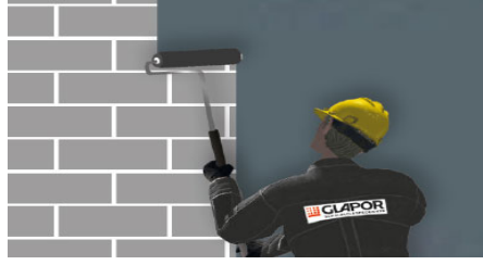
Reinigen und Grundieren
