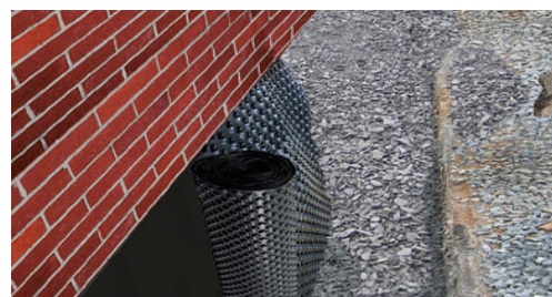
Noppenbahn verlegen / Kiesschüttung anfüllen
