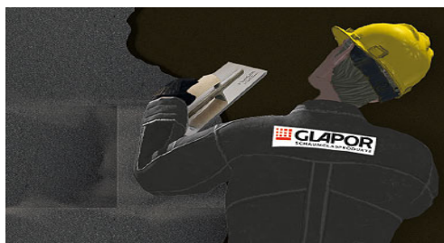
Deckabstrich und Abdichtung herstellen
