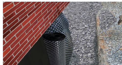
Noppenbahn verlegen / Kiesschüttung anfüllen
