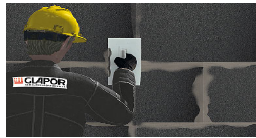
überstehenden Kleber entfernen
