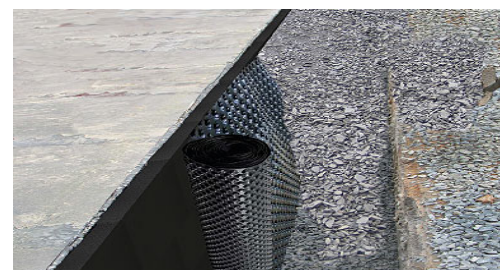
Noppenbahn verlegen / Kiesschüttung anfüllen
