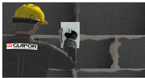
überstehenden Kleber entfernen
