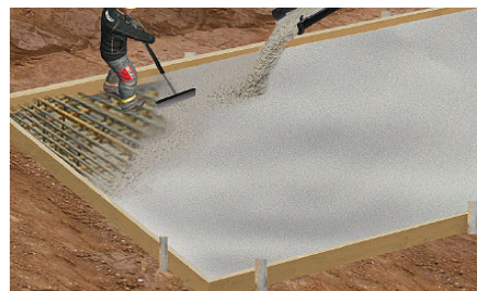
Betonplatte herstellen
