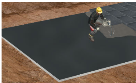
Heißbitumen/Kaltbitumenkleber aufbringen
