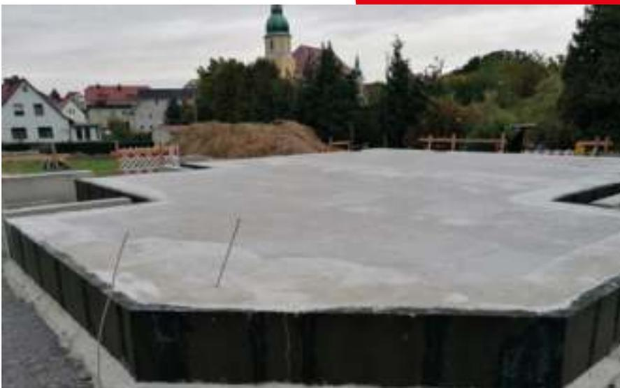
GLAPOR RDS-Schalungselemente gibt es in unterschiedlichen Höhen und Längen. Unsere GLAPOR Spezialisten helfen Ihnen bei der richtigen Dimensionierung. Die Verklebung der RDS-Fugen soll mit dem bitumenfreien GLAPOR Systemkleber TX2K vorgenommen werden. Verlegehinweise beachten!
