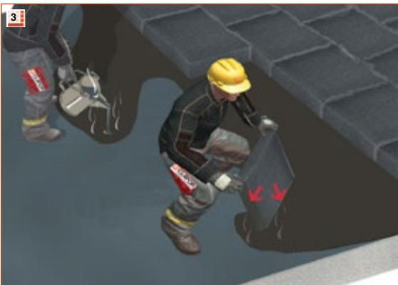
3 GLAPOR flex Heißbitumen ausgießen, die Dämmplatten mit zwei Seiten in die Klebmasse eintauchen...
