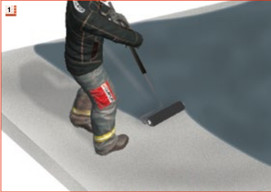
1 Dachfläche säubern und mit Bitumen- voranstrich / Bitumenemulsion vorstreichen und ablüften lassen. Verbrauch: ca. 0,3 kg/m 2 .
