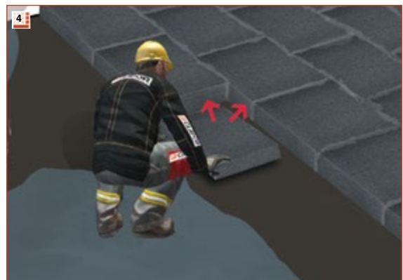
4 ...und diagonal einschieben, damit die Längs- und Querfugen mit Bitumen gefüllt werden.
