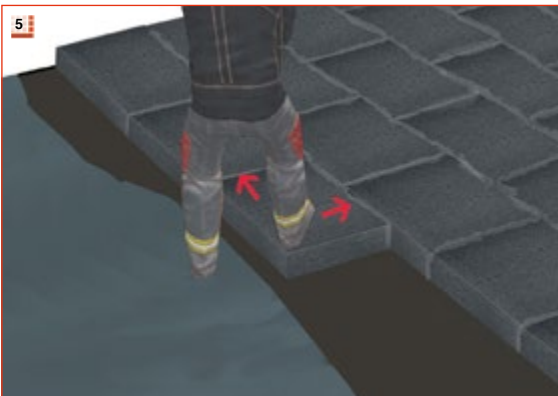
5 Dämmplatte kurzzeitig gegen verschieben sichern. Je nach Ebenheit des Untergrundes. Verbrauch: 5 bis 8 kg/m 2 .
