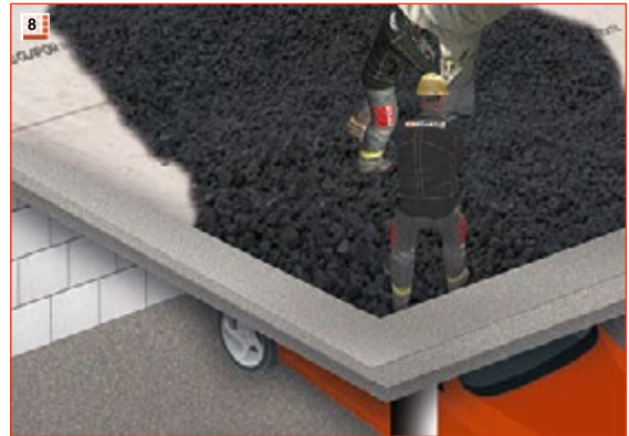
8 Schaumglasschotter mit Überhöhung einbauen und verteilen. Überhöhung je nach Belastung der Schotterschicht 1,2 bis 1,3.
