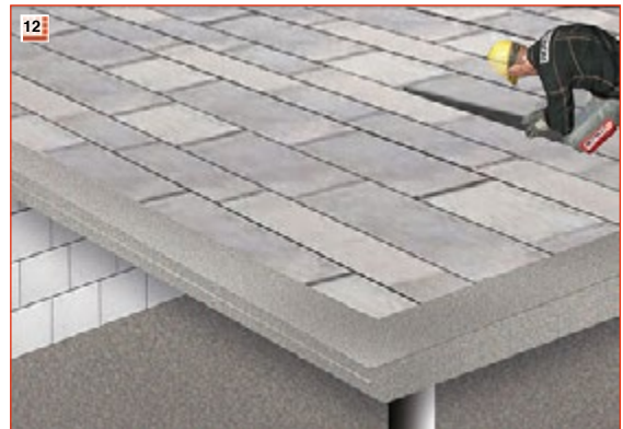
12 Plattenbelag über dem Kies/Splittbett einbauen.
