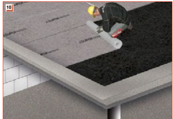
10 GLAPOR Geotextil als Trennlage auf die Dämmschotterschicht verlegen.
